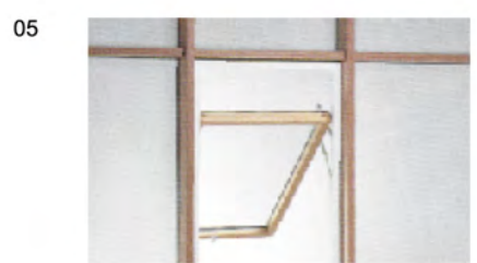
ACRISTALAMIENTOS los acristalamientos y el muro cofina se realizarán con carpintería mixta de madera y acero galvanizado.
